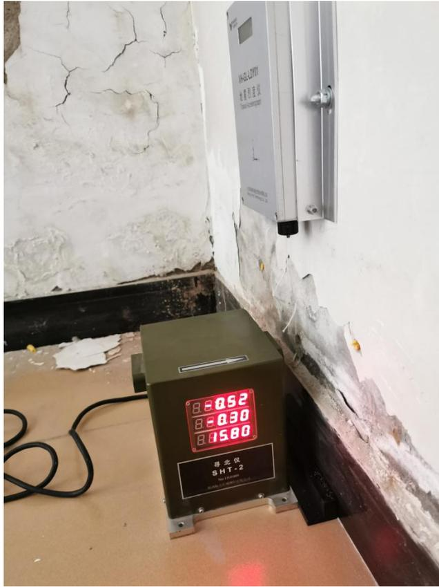
⑤ 确定烈度仪设备放置水平、安装方向无误后，用碰撞螺栓固定。
